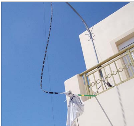
Der recht „spektakuläre Hitzeschild“ am Balun der G5RV-Einspeisung mittels hellem T-Shirt
